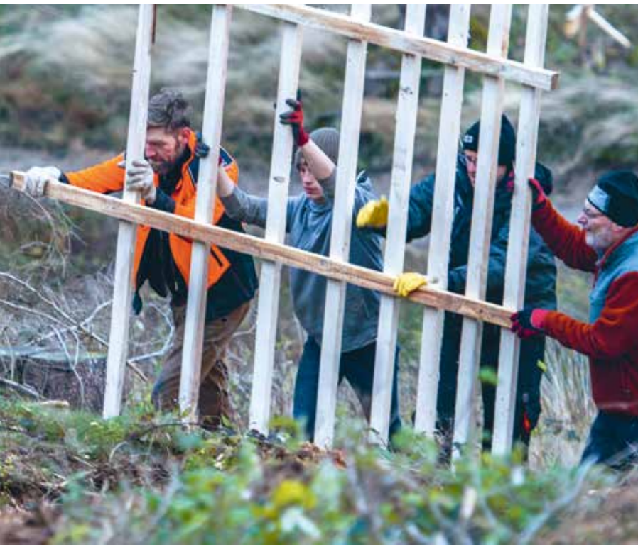
Aufstellen der gebauten Hordengatter in Goslar
