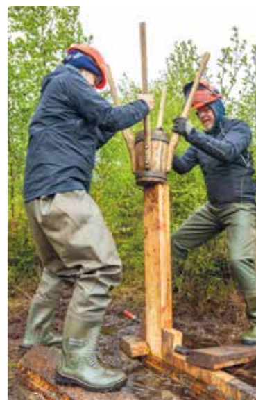
Konzentration und Kooperation an der Rammkatze bei der Moorwiedervernässung in Lichtenau
