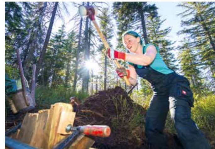
Eibenstock: Freiwillige beim Einschlagen von Grabensperren
