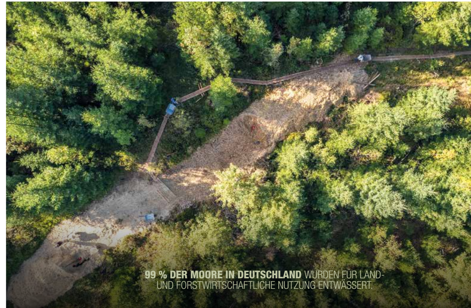
Grabenverfüllung in Eibenstock
