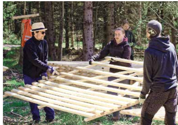
Bau von Hordengattern in Meiningen
