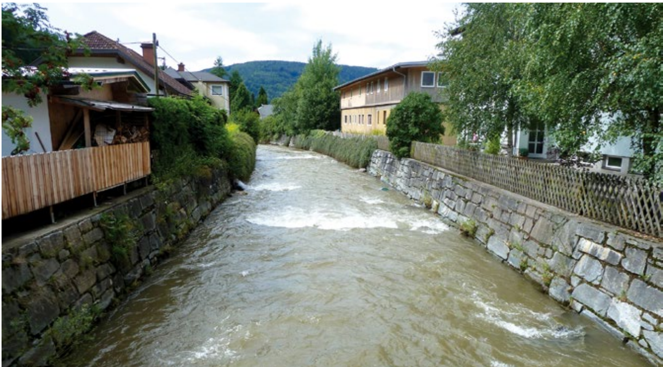
Für den Hochwasserschutz ausgebauter Mittelgebirgsfluss; Quelle: Stephan Naumann
